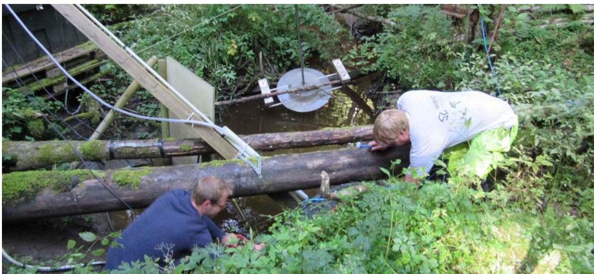
Arbeid ved hovedstasjonen i den nordre Lundbekken.
