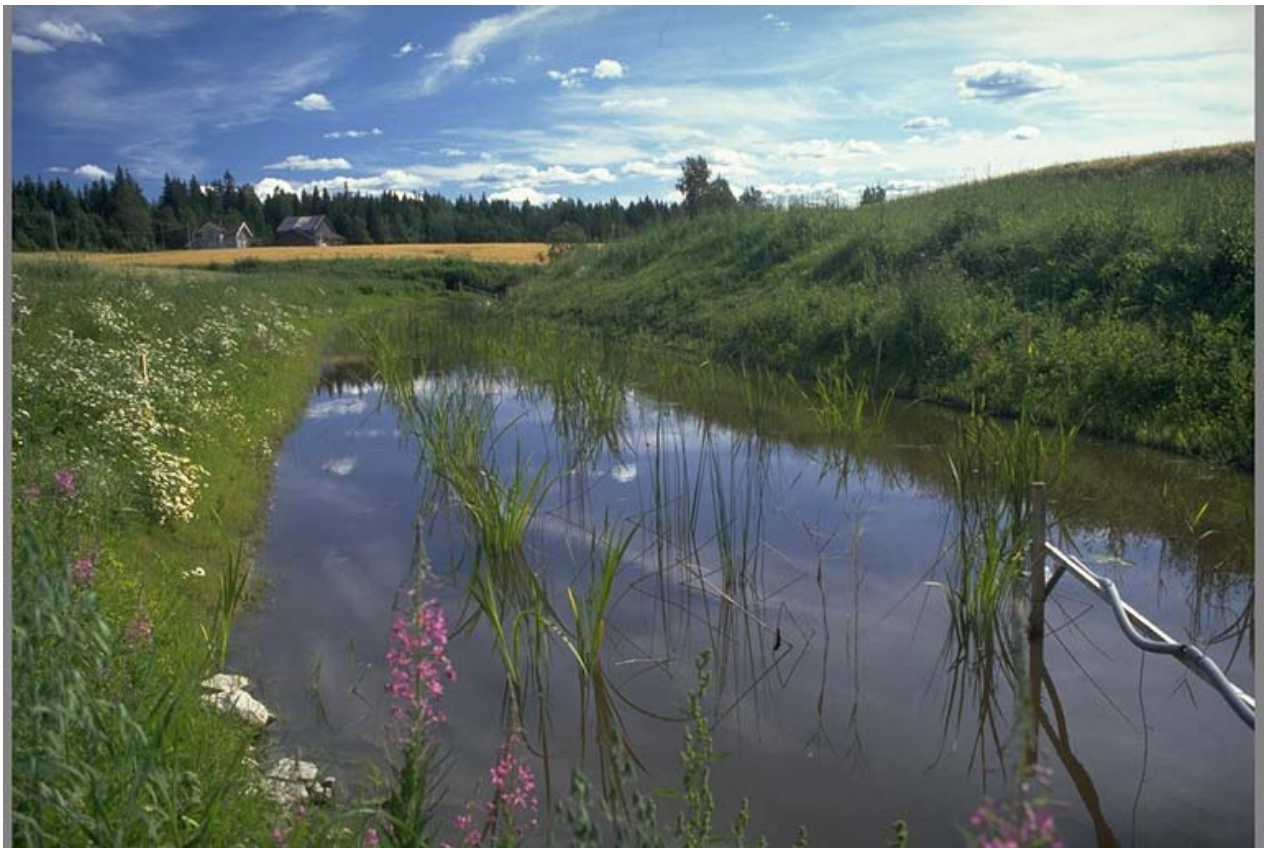
Vegetasjonsfilter i fangdam like etter utplantning. (Foto Bent Braskerud)
