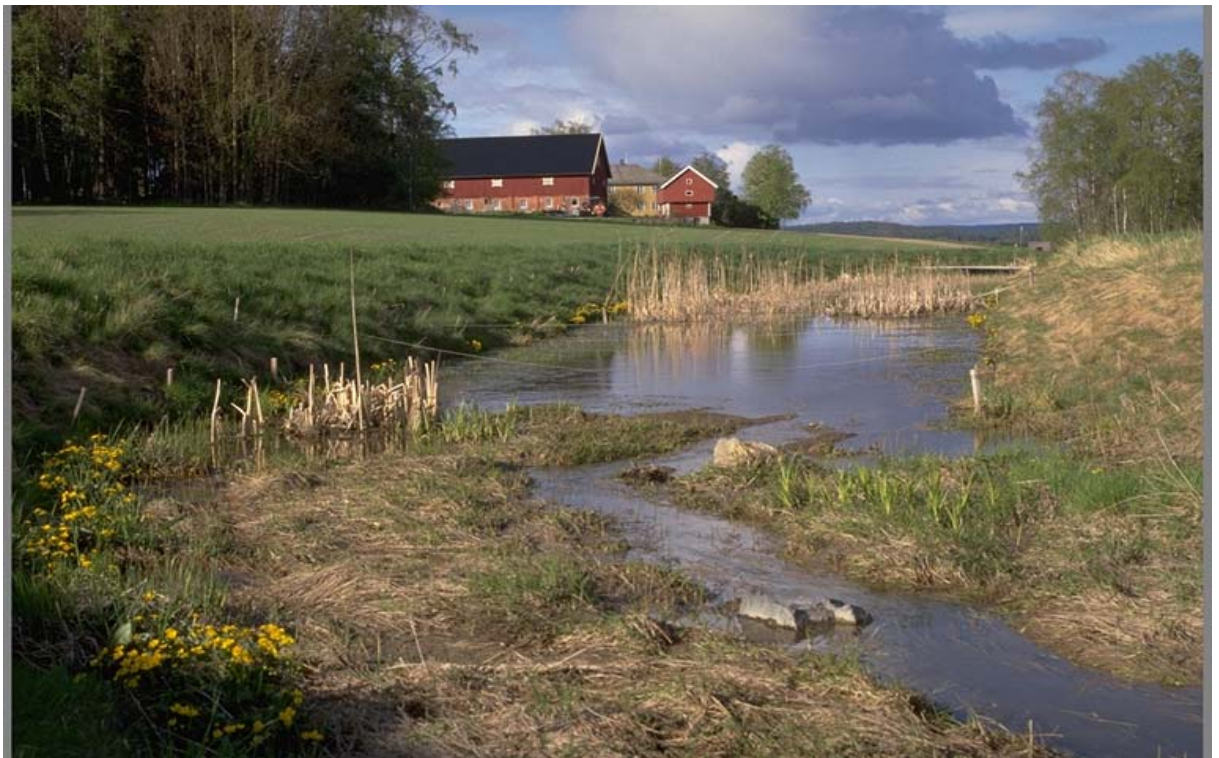
Fangdam med sedimentasjonskammer og vegetasjonssone. (Foto Bent Braskerud)
