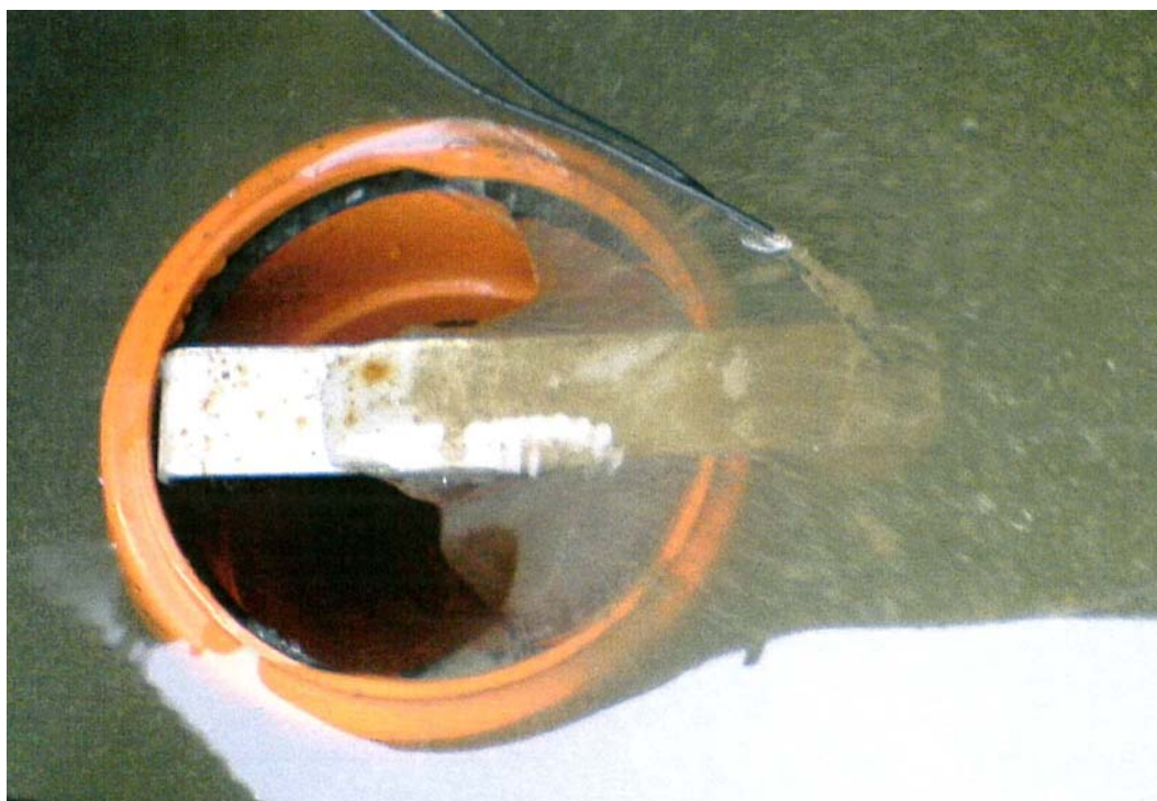
Figur 44. Slamflukt under pumpesekvens for et WehoMini anlegg.
