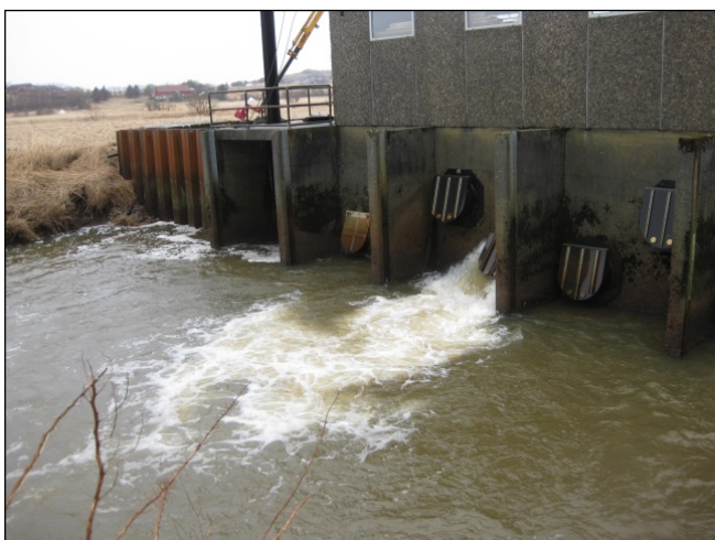
Figur 2. Utpumping av vann fra Skas-Heigre-feltet. Foto Bioforsk.
