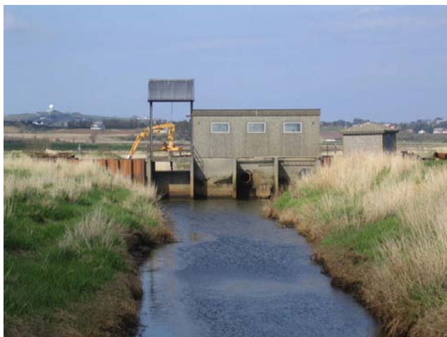
Figur 2. Pumpestasjon i Skas-Heigre kanalen. Foto: J.Deelstra, Bioforsk
