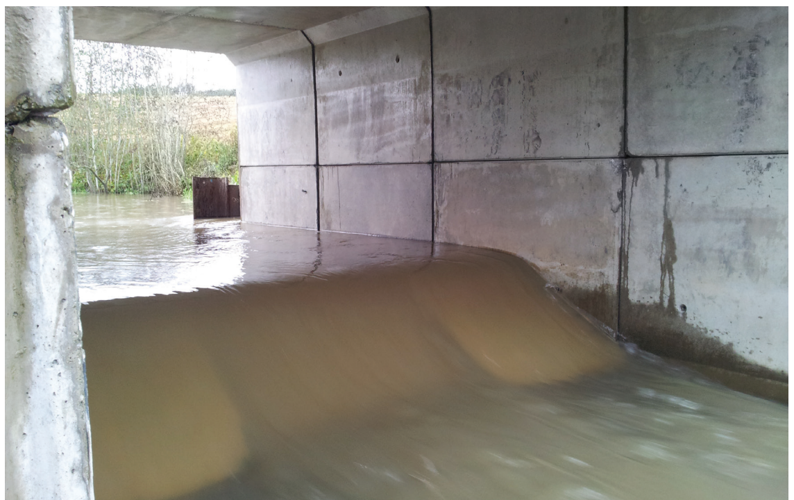
Figur 1. Vannstrømmen gjennom Crump-overløpet i Hotranelva.
