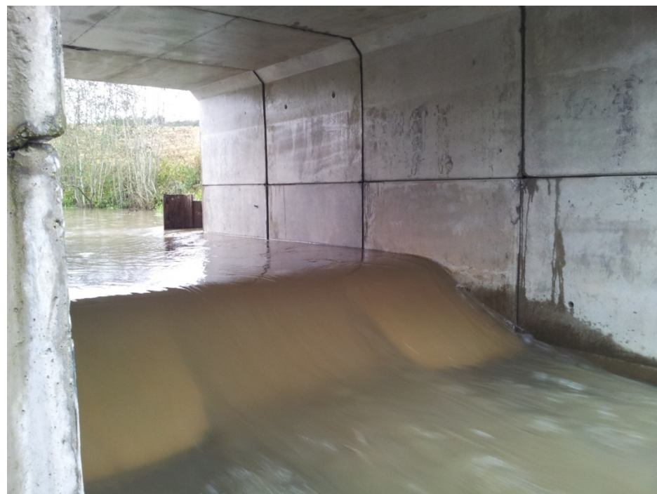
Figur 1. Vannstrømmen gjennom Crump-overløpet i Hotranelva.
