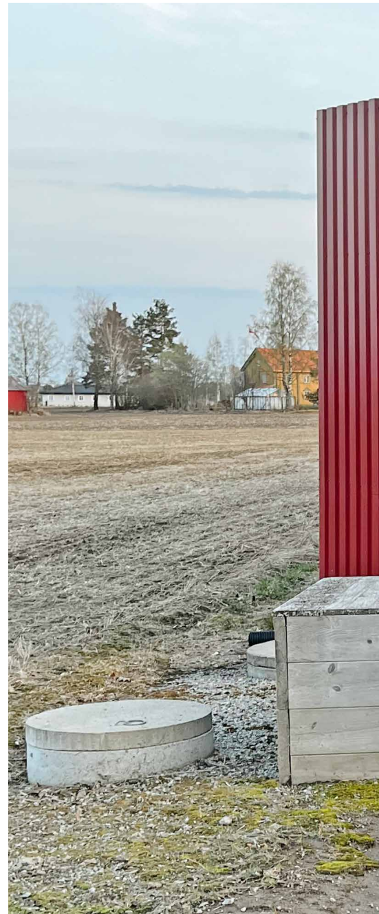
Effektivt: Vaskeplass og biofilter hos bonden Bernt
